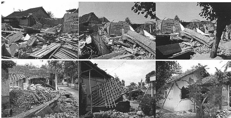
写真-5 Bantul 市街地の建物の倒壊
