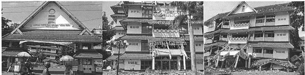
写真-10 カレッジの校舎の損壊（Sewan）
