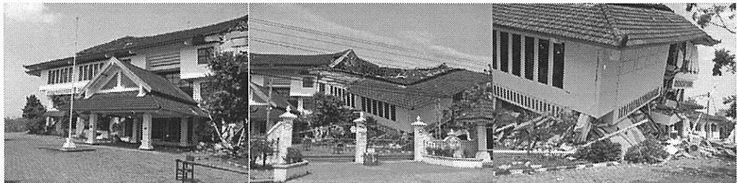
写真-9 鉄筋コンクリート構造の建物の崩壊（Sewan）
