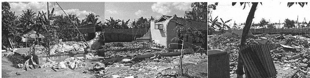
写真-20 ほぼ壊滅した集落の様子 (Gantiwarno)
