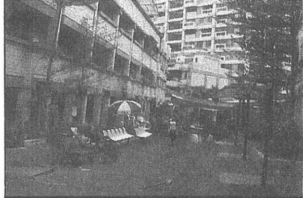
図-10 北端（左）マンションの傾斜(奥側：Bブロック)
