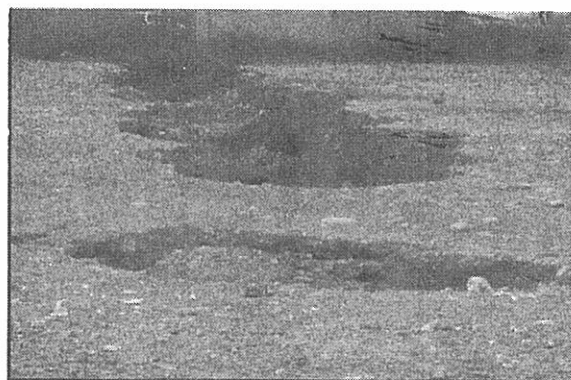
図-18 コンクリート排水溝近くの地盤陥没
