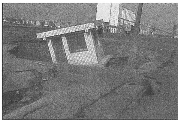
図-6a 護岸背後での陥没による被害
