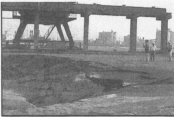
図-4 護岸背後地盤での液状化
