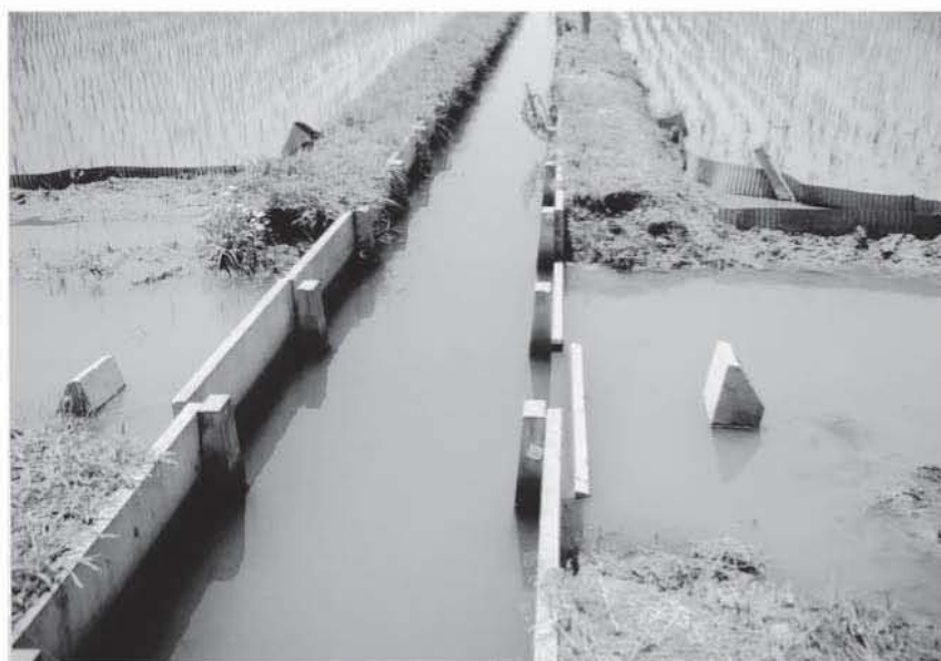
Fig.11 2004/05/24 の代かき期の水路溝畔陥没
