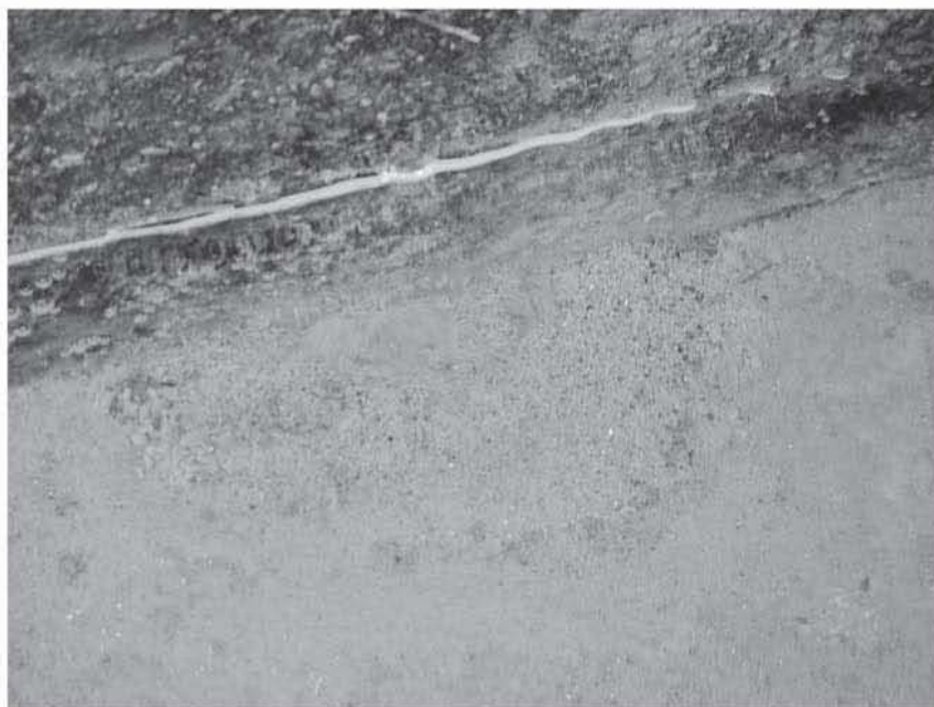
Fig.10 隙間からの細土粒子の噴出現象(2003/08/24)
