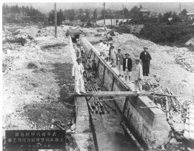
暗渠工事の様子（柚谷川？）
