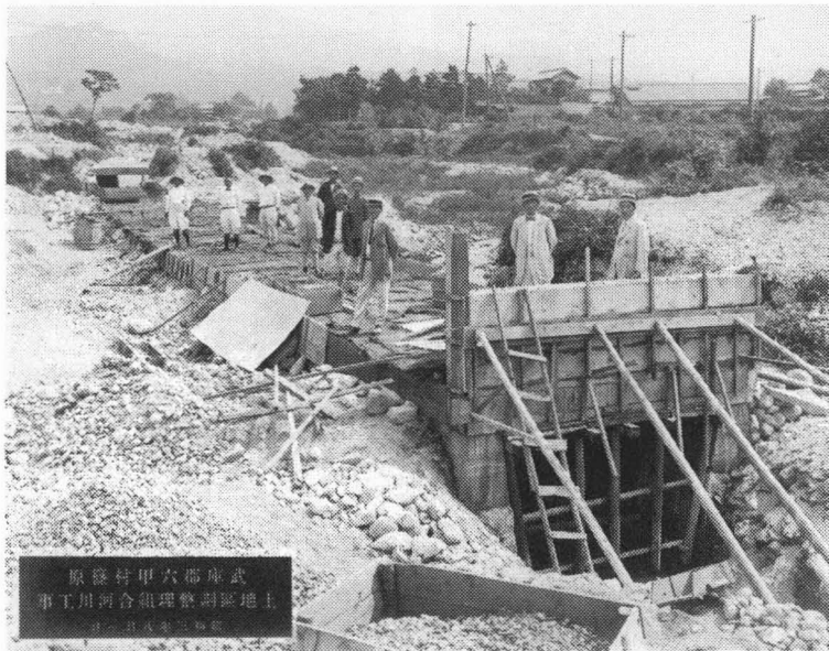
六甲川の暗渠工事（合流点付近）
