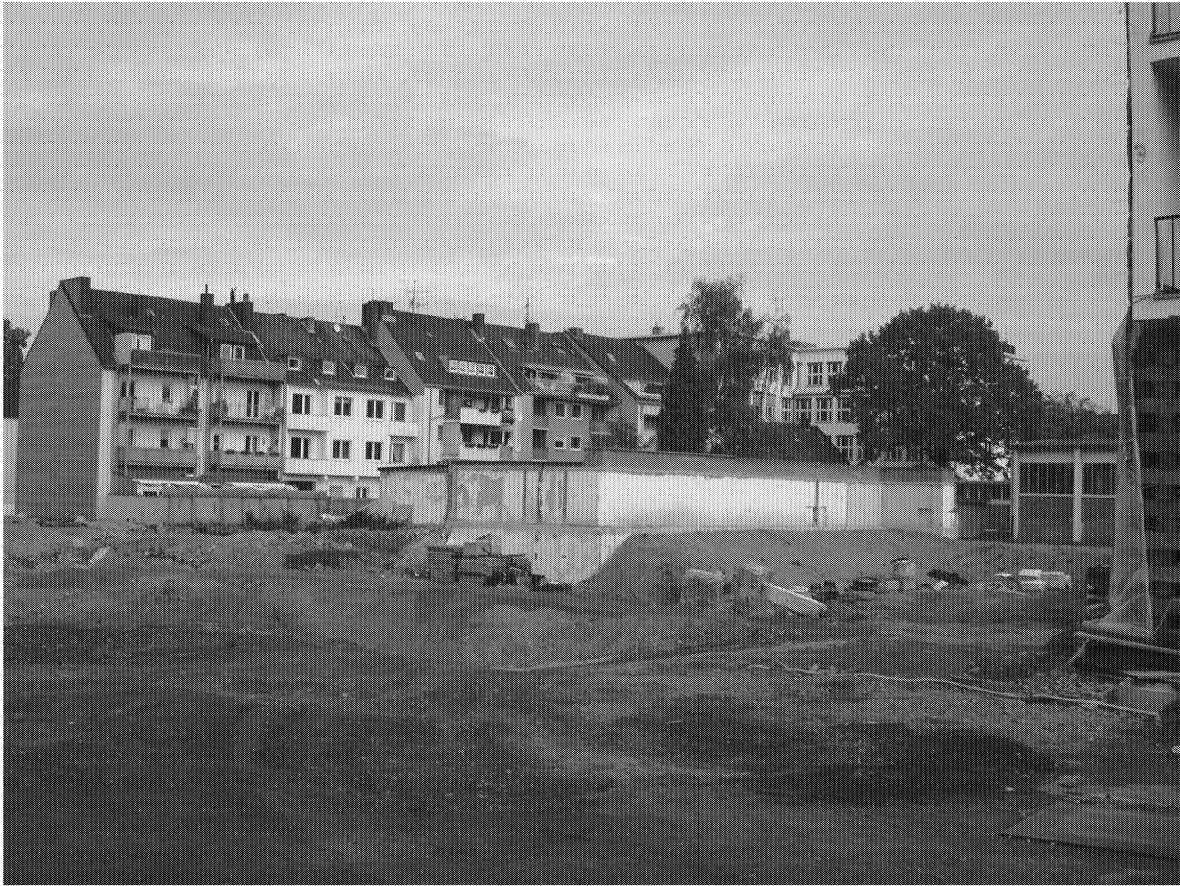
Ortswechsel der Baufahrzeuge in diesem Foto zwei Tage später zeugen von Aktivität an der Baustelle.
