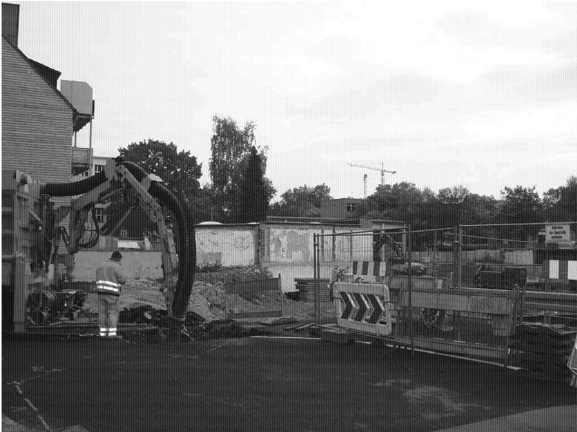
Eine Bohrung im nördlichen Bereich der U-Bahn-Baustelle.
