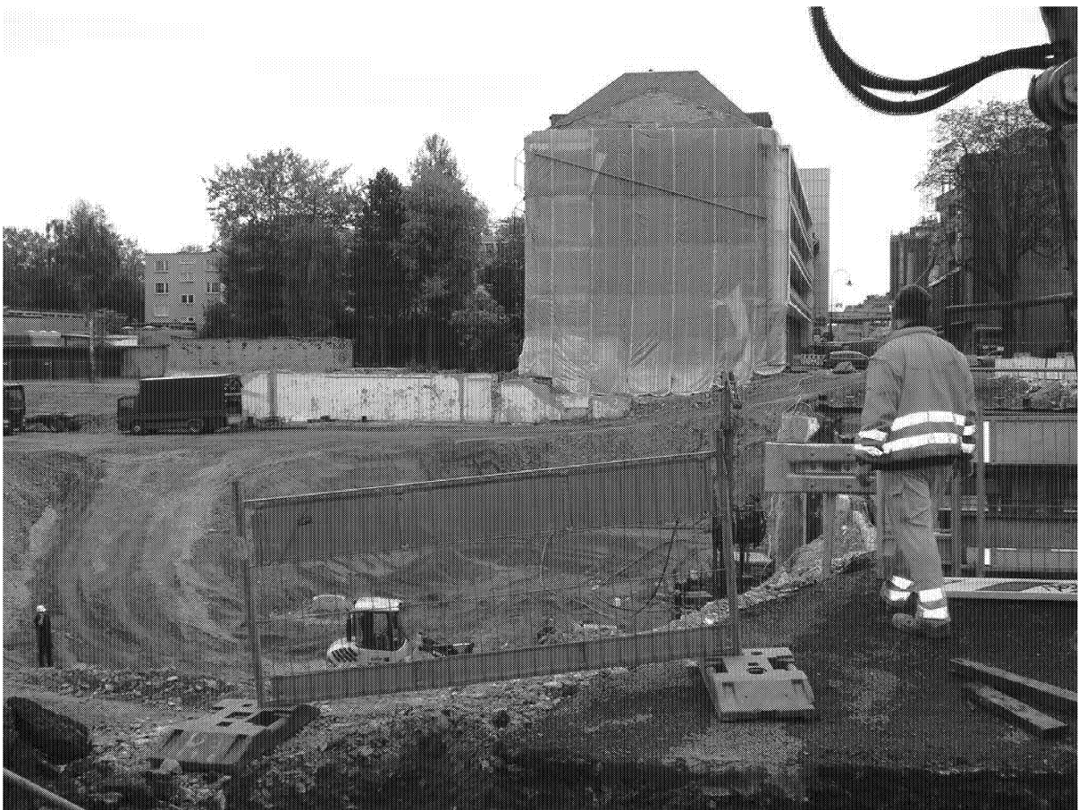
Links ein Bauherr in der Grube, und der Bauarbeiter oben von der Straßenverwaltung (?) zeugen von Tätigkeiten an der Baustelle.
