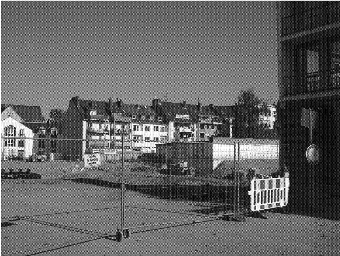
Die abgesperrte Baustelle. (Sie zu betreten war auch mir – ohne eine Genehmigung – nicht gestattet). Schutt und Schutzdach sind bereits entfernt im Oktober 2009. Ebenso das halb mit eingestürzte Haus, das in der Mitte dieses Fotos gestanden wäre.
