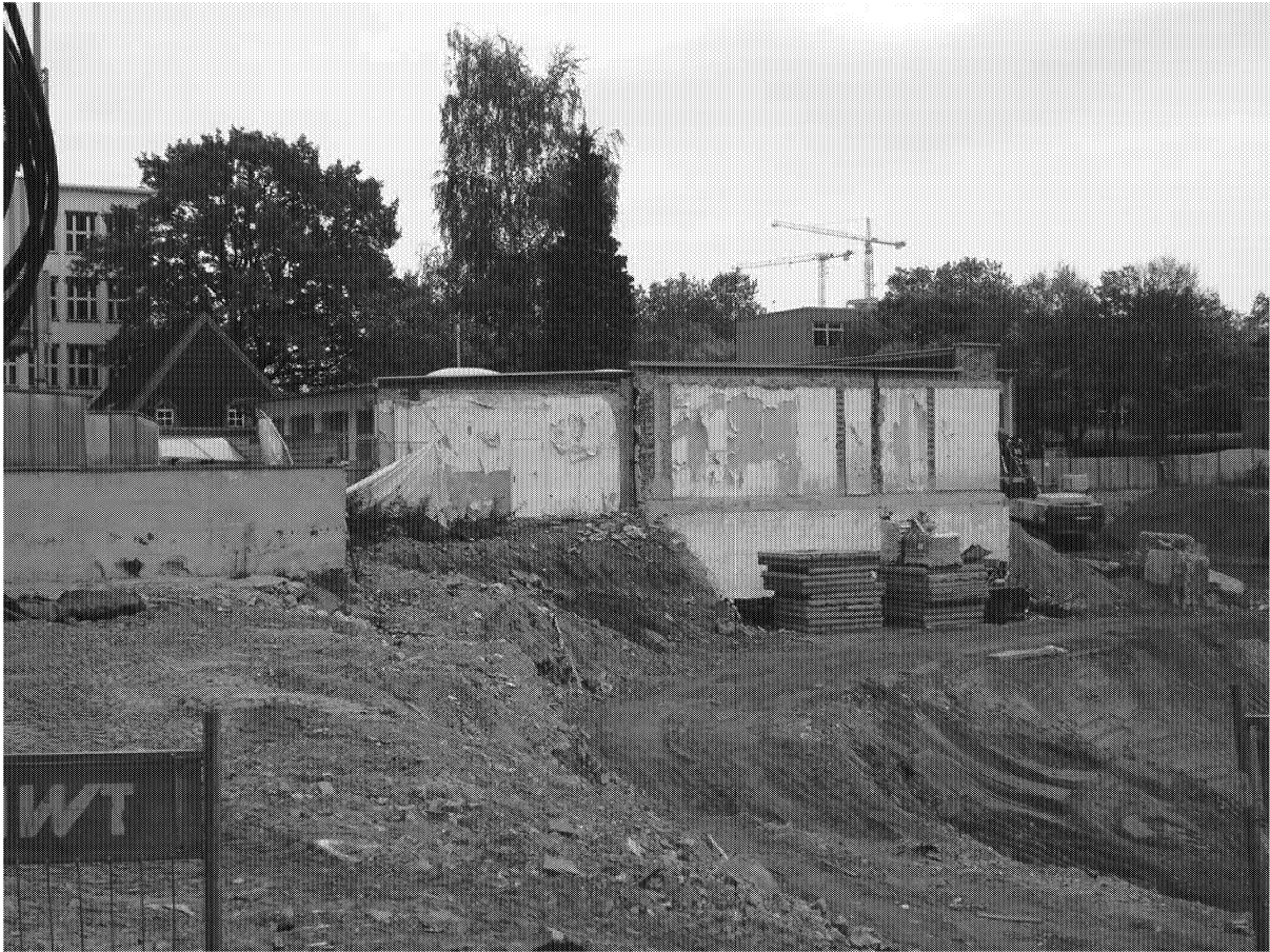
An die Baustellenzufahrt angrenzende Gebäude.
