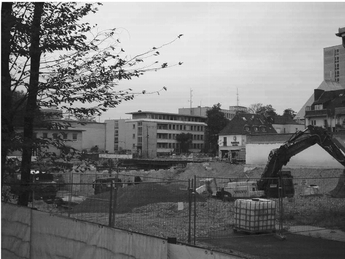
Blick auf die Baustelle von Ost nach West, vom Innenhof der „Severin-Schule“ für Sehbehinderte vom Landschaftsverband Rheinland (LVR).
