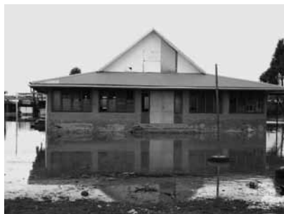
写真4 満潮時に水浸しになった集会所
