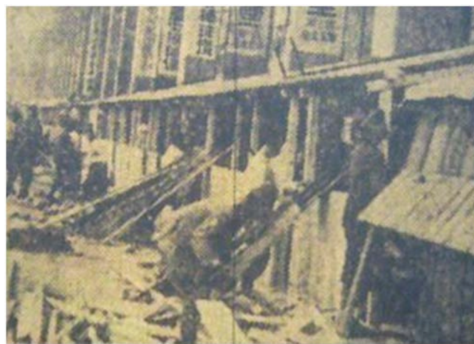
【写真4】 三宮高架下舗道に建設中の連続型店舗 (出典：『神戸新聞』1946年10月19日)
