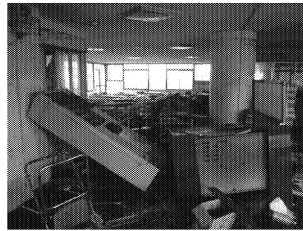
▼1階部分が津波で水没した建物
