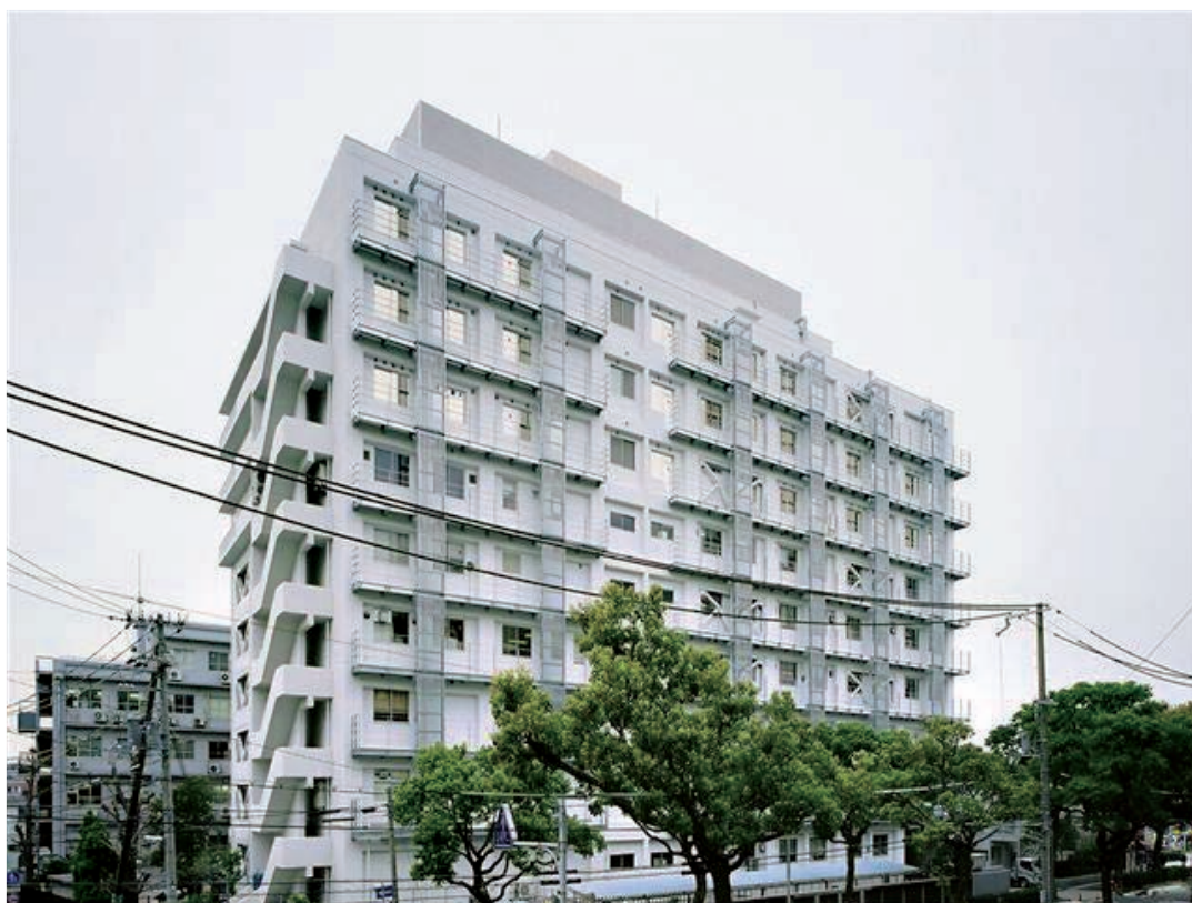
研究棟 B 改修後の屋外耐震補強状況 (第 1 期工事)
