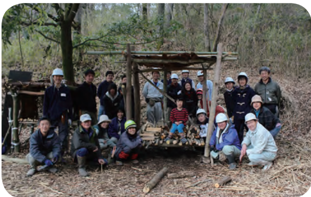
薪小屋の完成!
