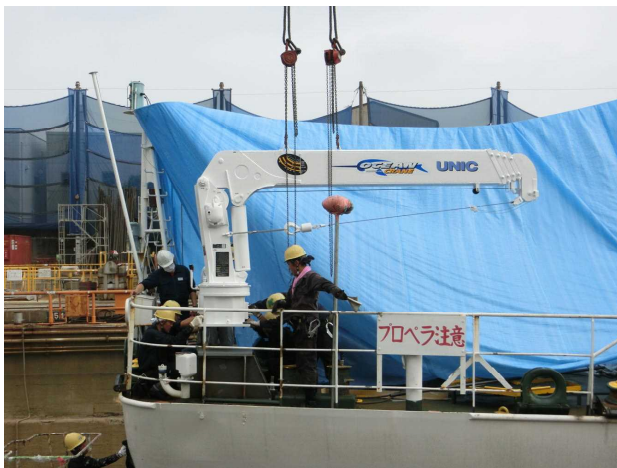
図4 ユニック・オーシャンクレーン搭載
