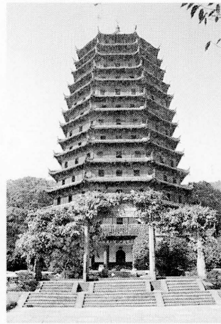
図8 杭州の八角十三層の六和塔
