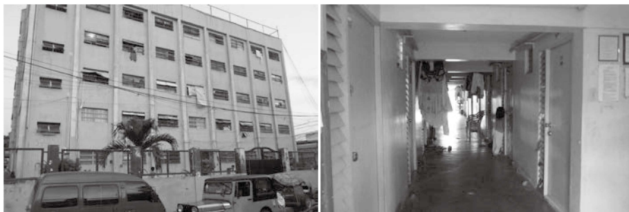
左：図 13 建物外観/2010.09.18
