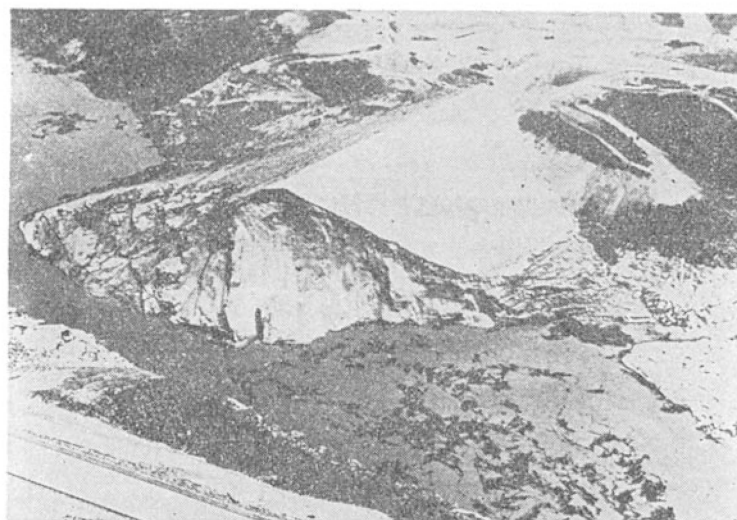
Fig.9 ティートンダムの決壊後の状況
