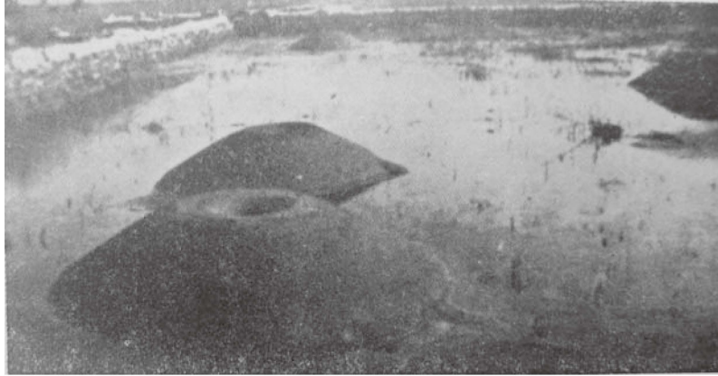
Fig.10 典型的な噴砂口(W.J.Turnbull) (アースダムとアースロックダム p.63) (Sand boils in Sack Sublevee Basin near Friars Point, Miss., 1937 High water) (Turnbull and Mansur, 1961a, 1961b, 1961c)
