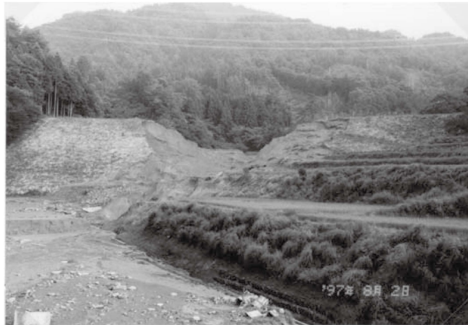
Fig.20 麻生ため池堤体の決壊(1997年8月2日)
