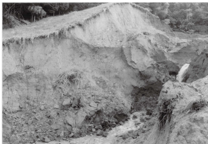
Fig.19 江良ため池決壊部分の近接写真 (下部に青灰色の粘土(旧堤体), 上部にマサ土がみえる)
