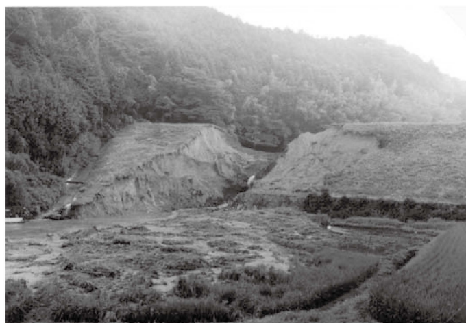
Fig.18 江良ため池堤体の決壊
