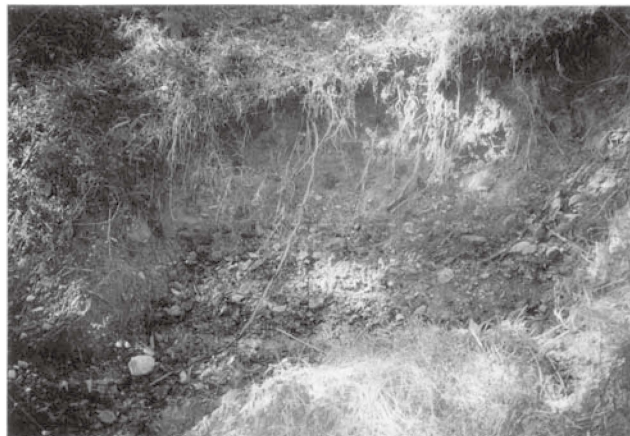
Fig.29 眠谷池における進行性法くずれ
