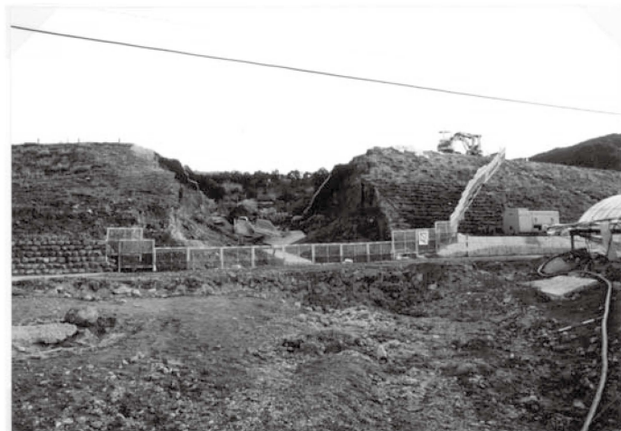
Fig.17 決壊した堤体を下流側から望む(1997年4月10日)
