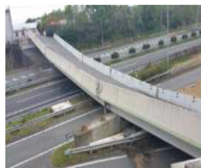
写真-1 県道小川嘉島線 府領第一橋
