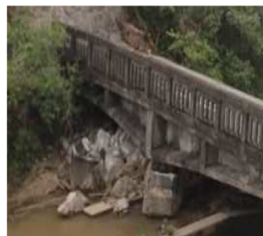
写真-2 平田・小柳線 田中橋
