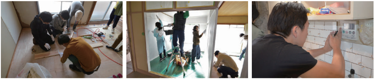
図2. フローリング張り、ペイント、タイル張りの作業風景
