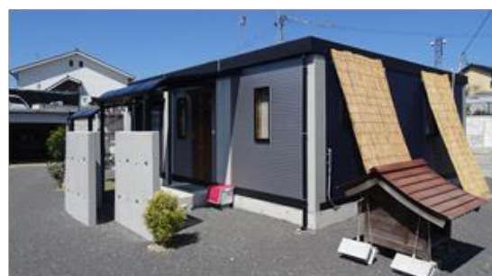
写真 5.2 生活機能を完備した自力仮設
