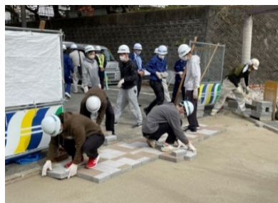
写真1. 作業風景 (左・ブロック敷設前に地面をならす、中央・ブロックを敷設、右・組み立てたソーホース)
