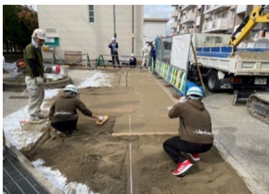
写真1. 作業風景 (左・ブロック敷設前に地面をならす、中央・ブロックを敷設、右・組み立てたソーホース)
