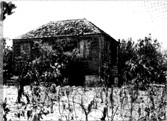
<写真②> 廃屋はあちこちに見られる。
