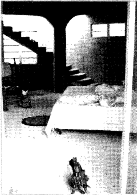
<写真③④> 階段も完成し二階へ通じる。
