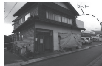
写真6 従前の住宅(震災直後の状況・写真5の敷地)
