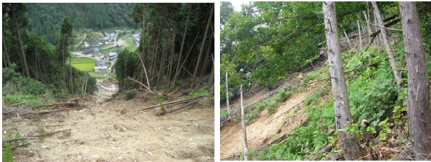
写真 5 崩壊地周辺の状況 兵庫県撮影
