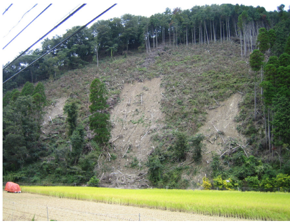
写真 3 2006年7月の豪雨によって発生した山腹斜面崩壊の事例 (兵庫県姫路市安富町末広)
