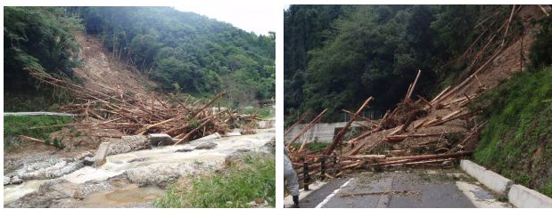
写真 4 斜面下部の状況 (崩壊発生2日後) 兵庫県撮影
