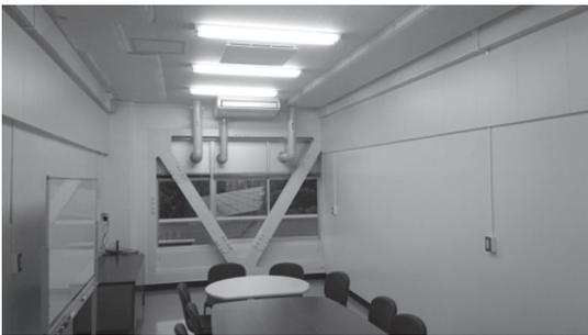
図9 吸音体の設置状況(上：作業中の側壁面の状況。下：完成後の状況。)
