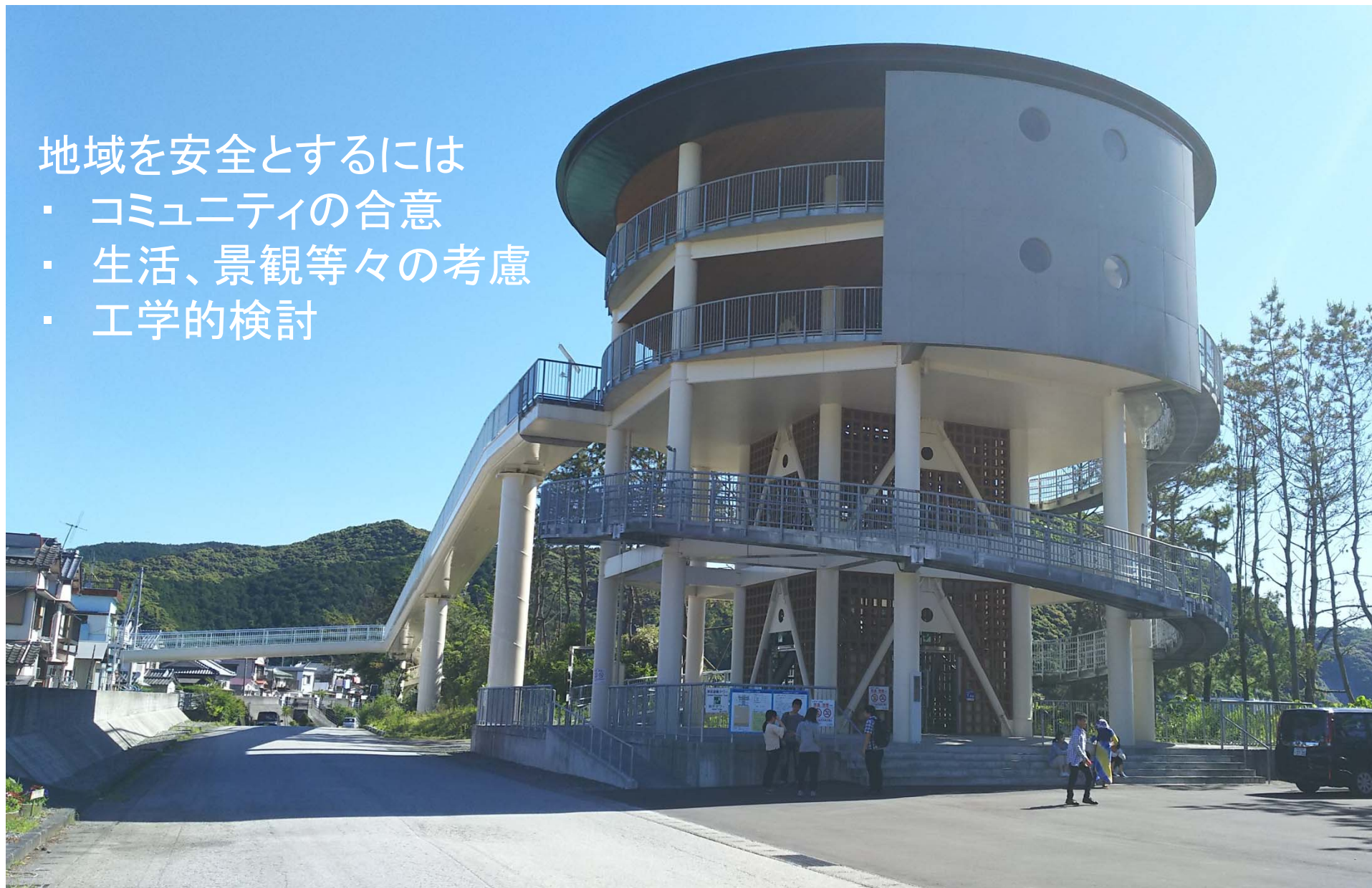
高知県中土佐町の津波避難タワー（2017年5月27日撮影）
