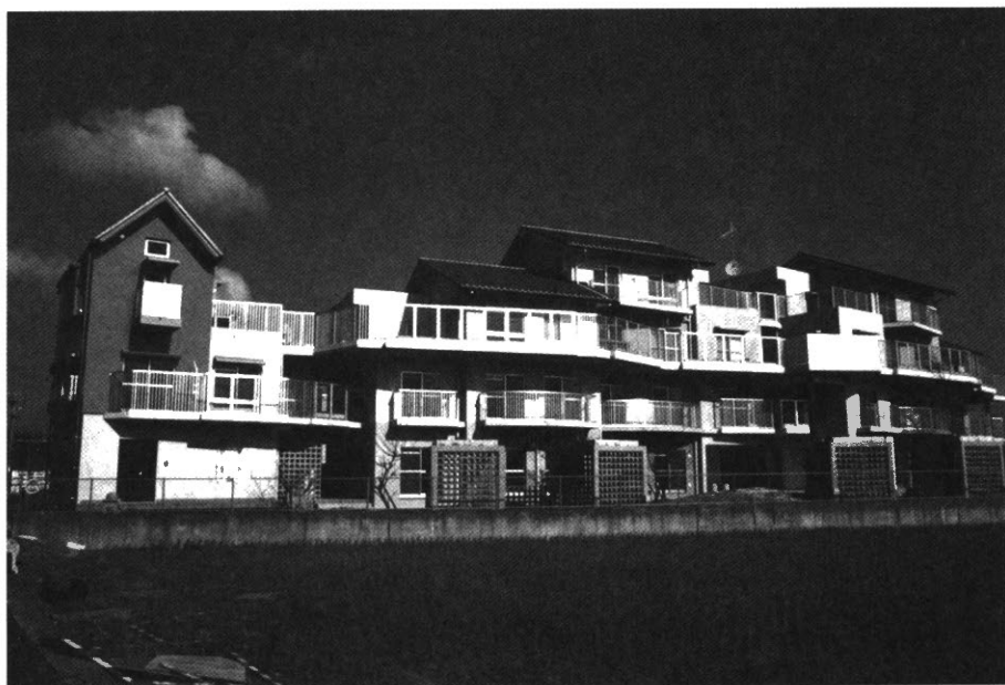
写真 1 建て替え後の島団地
