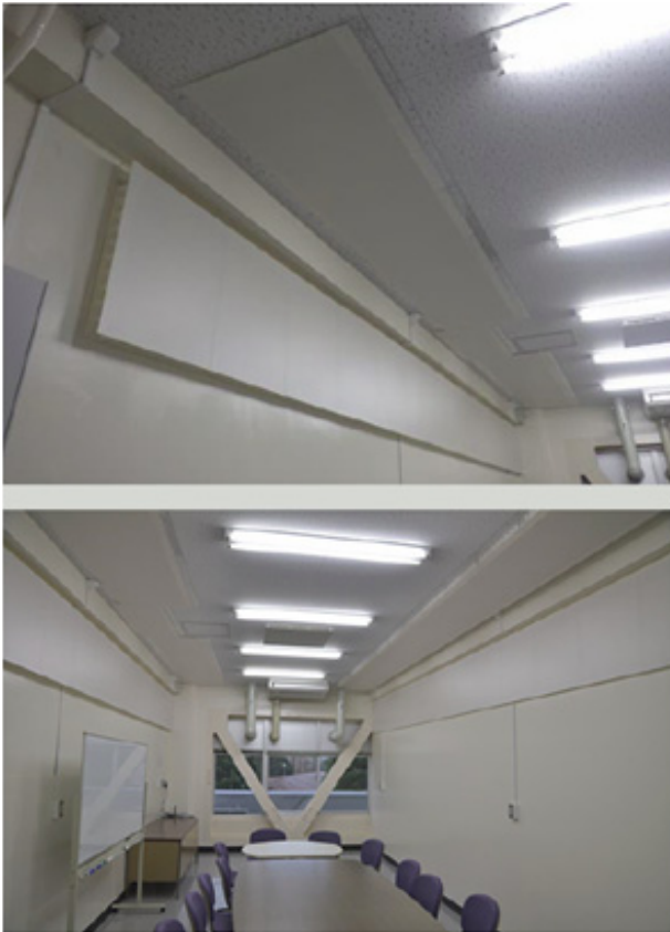
図-7 背後ハニカムを有する MPP 吸音体を会議室に実装した例 (上) 作業中の状況, (下) 設置完了状態 [3]。
