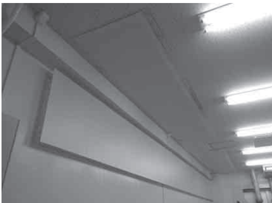
図9 残響過多の会議室に背後ハニカム付きMPP吸音体を取り付けて対策した事例
