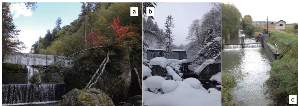
図 2. 調査地点の写真。a: Site5 の春～秋の状態、b: 落水もみられる Site5 の冬季の状態、c: 遡上可能と考えられる Site8。
