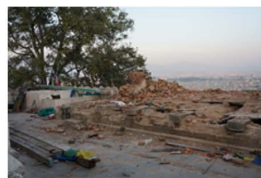
(b) 倒壊したままの建物(カトマンズ)
