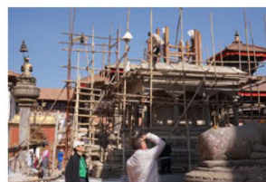
(d) 復旧作業中の寺院(バクタブル)
