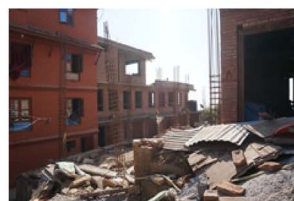
(h) 建築途中の建物(キルティプル)
