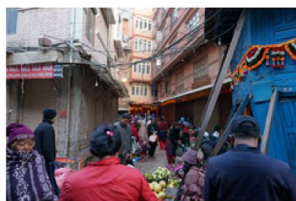
(a) 角材で衝立された建物(カトマンズ)
