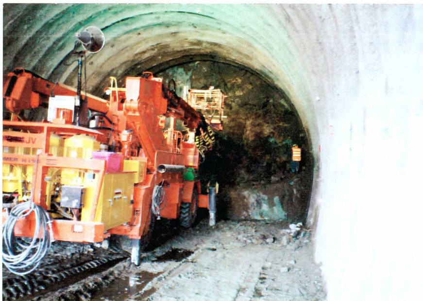
写真-1.1 トンネル掘削の例
