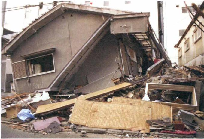
写真-3.1 共同住宅の被害写真（総2階建て）
