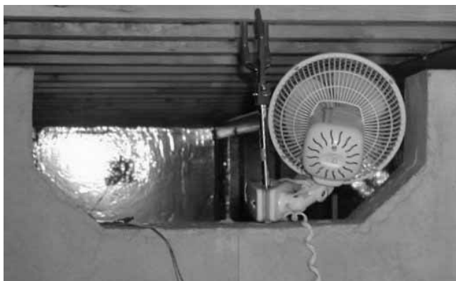
写真 2-1 補助ファン設置状況
