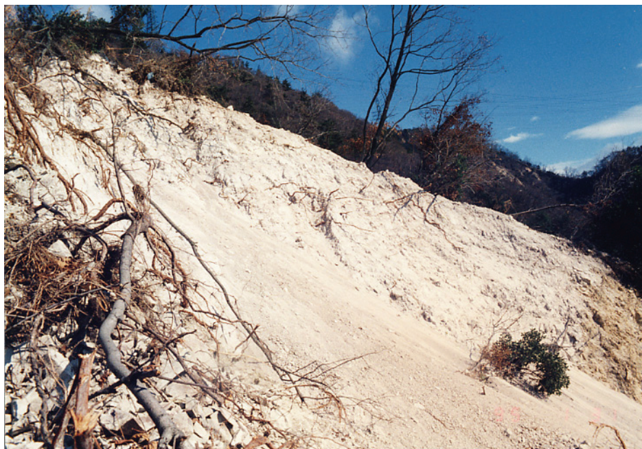
写真-3.2 兵庫県南部地震による斜面崩壊事例（その2）
