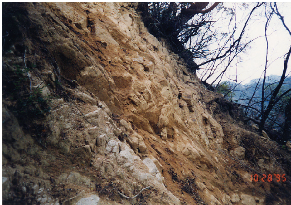
写真－3.1 兵庫県南部地震による斜面崩壊事例（その1）
