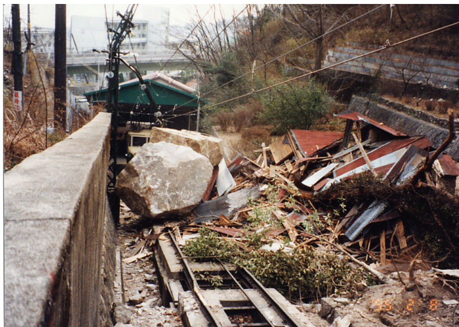
写真-3.1 兵庫県南部地震による斜面崩壊事例（その3）
