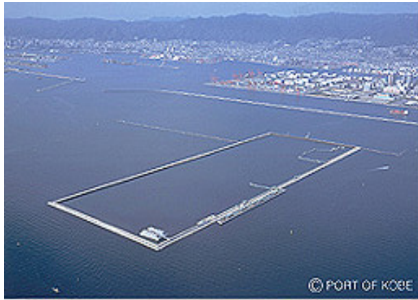
図-2.10 神戸沖埋立処分場 水深15m (資料:神戸市みなと総局HP)
