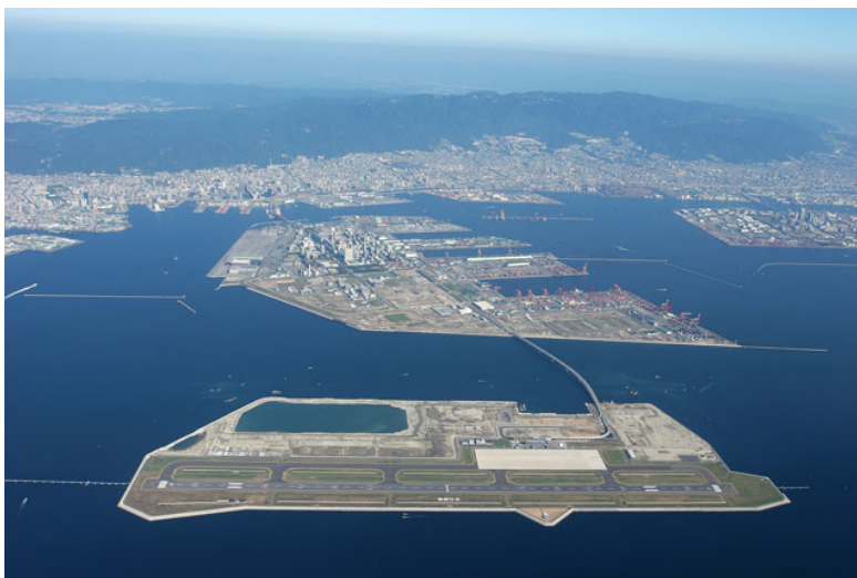
図-2.12 神戸空港 水深16m (資料:神戸市みなと総局HP)
