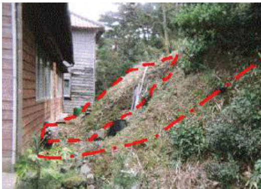
写真 5-9 急勾配斜面の破壊形態 (進行性破壊を繰り返し、崩壊土砂の一部 が家屋に達している)
