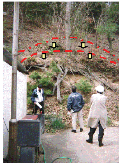
写真 5-12 急勾配斜面のオーバーハングの 状況(斜面中断の表層崩壊が進行し、上段が オーバーハング状態になっている)
