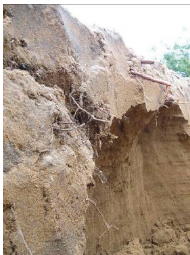
写真 5-15 崩壊後のテストピットの状況 (2)
