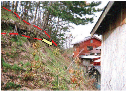
写真 5-7 急勾配斜面の状況 (斜面表層には植生が確認できる)
