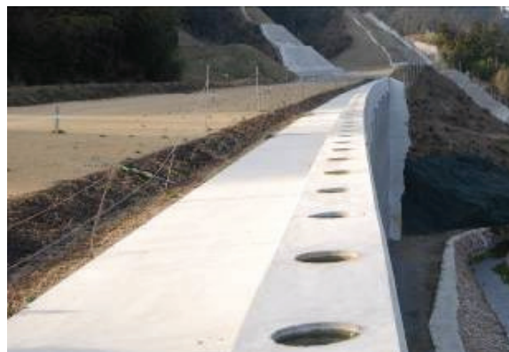
写真5-2 当該補強土壁工上部の路盤状態
