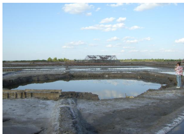
図-7.5 塩田に生じたシンクホール
