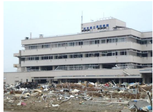
図-8.31 被災した県立病院
