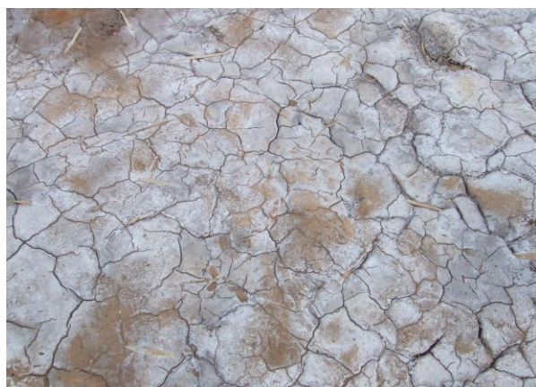
図-7.4 塩類が析出した地盤表面
