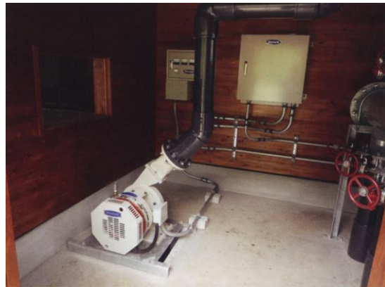
図 2-8 マイクロ水力発電の事例
