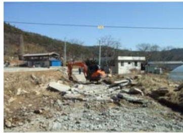
写真2 - 郷友人①の家新築のための敷地造成工事
