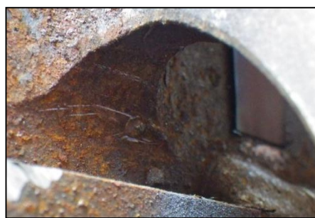
(d) CBS-29M : Crack initiation(at +3.0 \theta_p )
