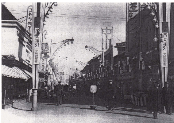
図1-11 1935年12月時点の元町通商店街の写真 (出典：商工省商務局『神戸市内商店街二關スル調査』商工省商務局 1936)
