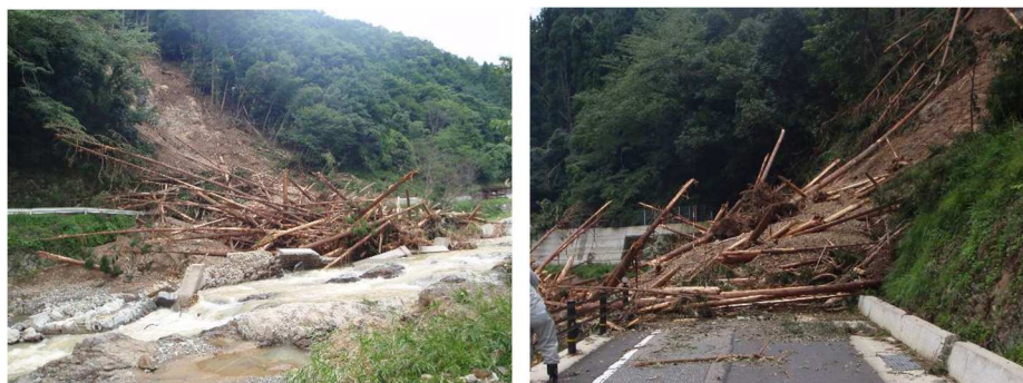
図3.54 斜面下部の状況（崩壊発生2日後） 兵庫県撮影
