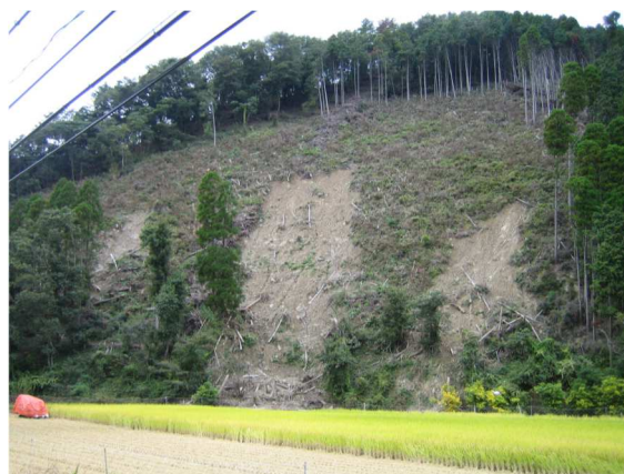
図3.6 2006年7月の豪雨によって発生した山腹斜面崩壊の事例（兵庫県姫路市安富町末広）
