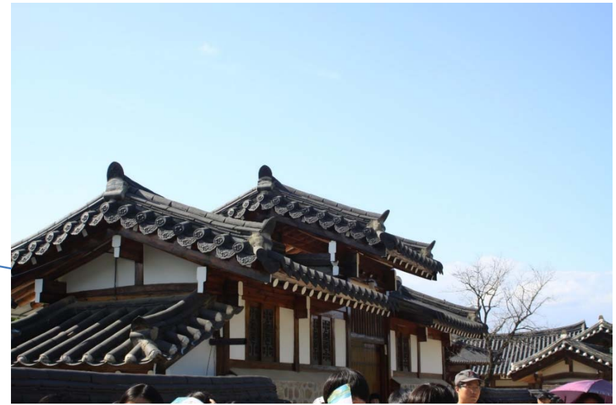
➤ 河回村内の重要な4つの建築物のうちのひとつ「北村宅」
