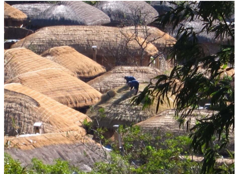
➤ 樂安邑城の民家の屋根の材料は全て藁葺であり、その葺き替えの作業の様子
