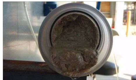
17 日経過後 排水側
