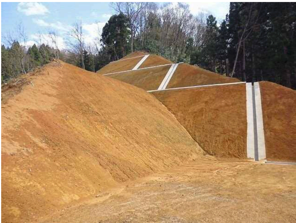
写真 4.6 安山岩風化残積土の切土法面
