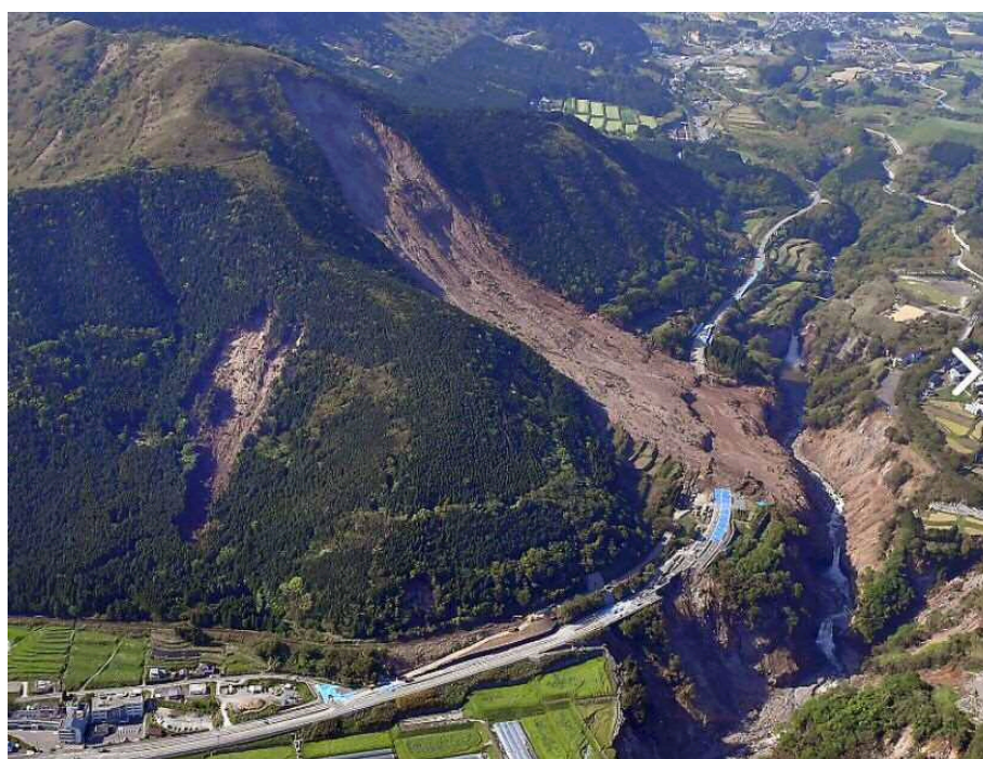
(b) 熊本地震による斜面崩壊と阿蘇大橋の崩落 8)
