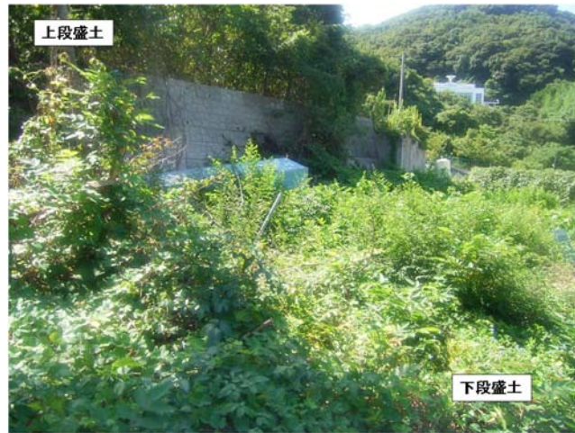
(a) 調査箇所全景 (写真①)
