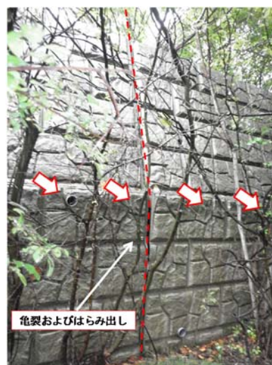
(d) 下段盛土壁 (写真④)
