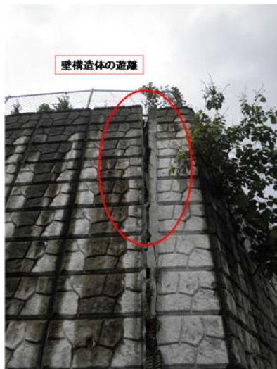
(b) 下段盛土壁 (写真②)
