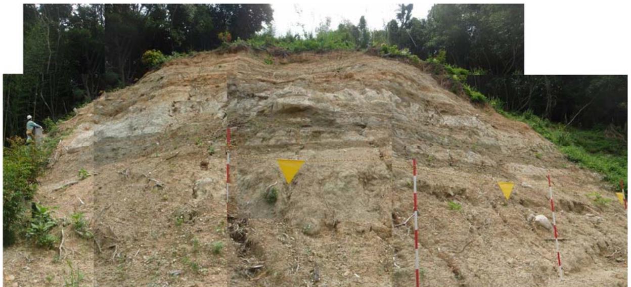
写真 6-4 崩壊地③における地層
