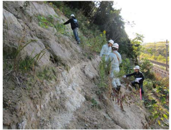
写真 6-3 斜面の様子 (崩壊地③)
