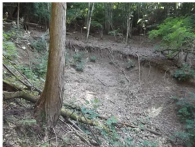
写真 6-5 崩壊地の状況
