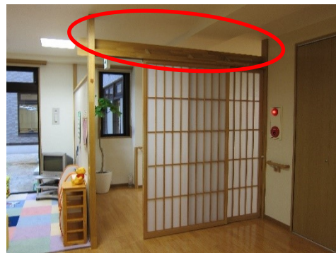
図2-4 ユニット入口上部が開放欄間 (特養④)
