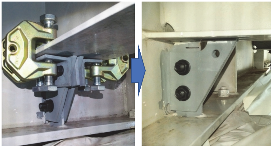
写真 8.4 当て板 type I 施工中・施工後状況
