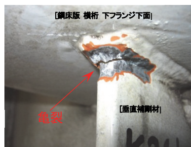
写真 8.1 亀裂状況
