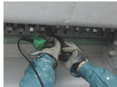
写真 5.6 TRS 締め込み状況
