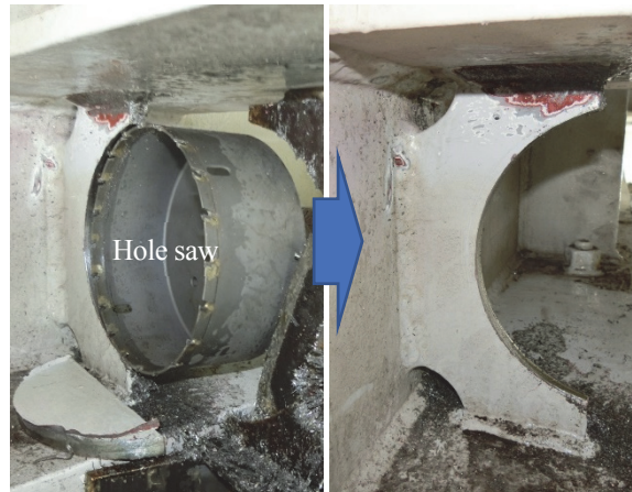
写真 8.3 type R75 施工中・施工後状況
