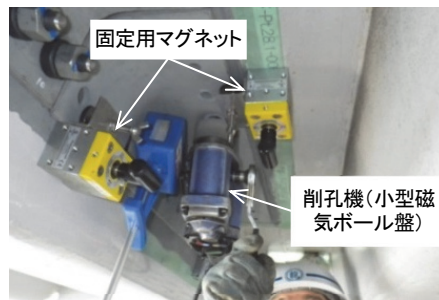
写真 5.5 ボルト孔の削孔
