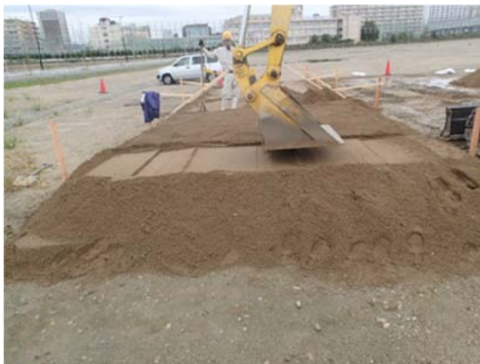
(a) D_c=75\% 盛土施工状況
