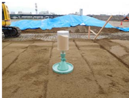
図6-8 現場密度試験(砂置換法)
