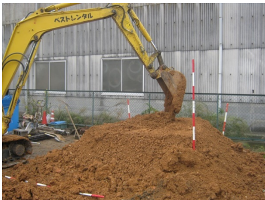
図6-9 試験盛土造成の様子
