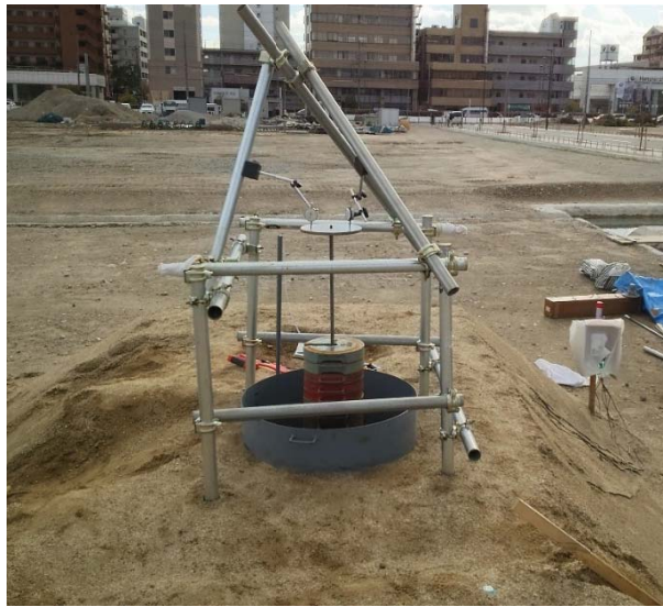
図6-22 原位置水浸沈下試験の様子
