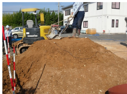
図6-10 タンパーによる盛土の締固め
