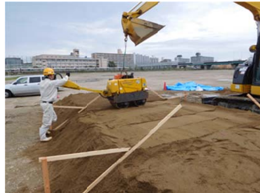
(b) D_c=85\% 盛土施工状況
