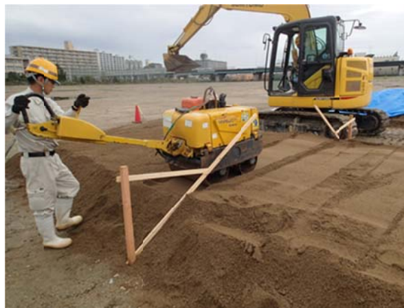
(c) D_c=95\% 盛土施工状況
