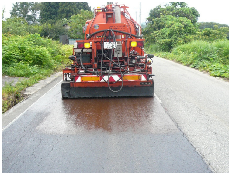
写真 3.8 フォグシール工法の施工状況
