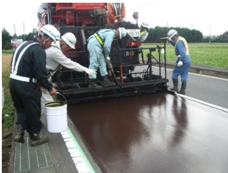
写真 3.10 マイクロサーフェッシング工法の施工状況
