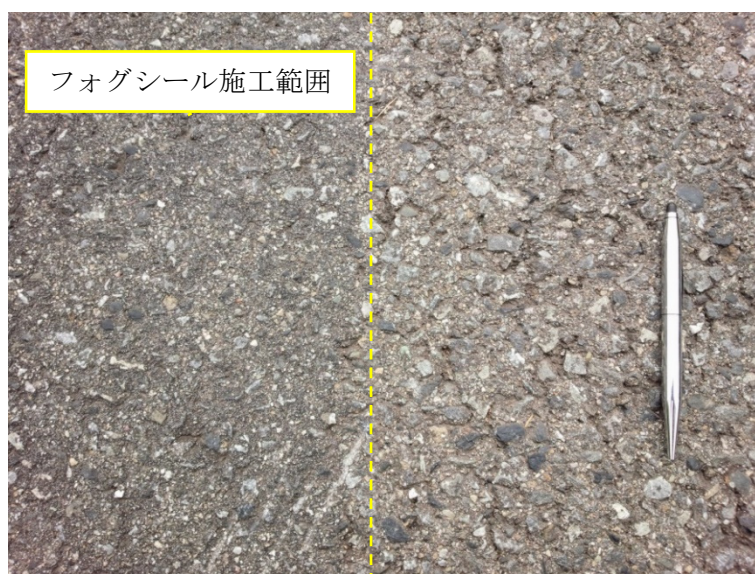
写真 6.10 調査箇所 C における施工境界の接写写真
