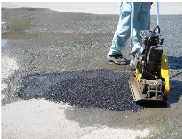
写真 3.2 パッチングの施工状況
