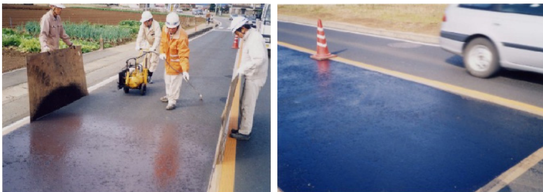
写真 6.2 調査箇所 A の施工時の状況写真
