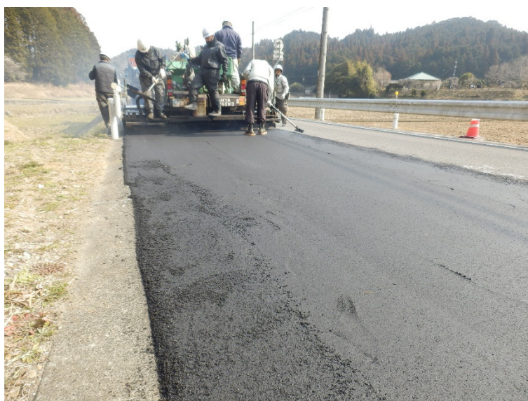
写真 3.6 薄層オーバーレイ工法の施工状況
