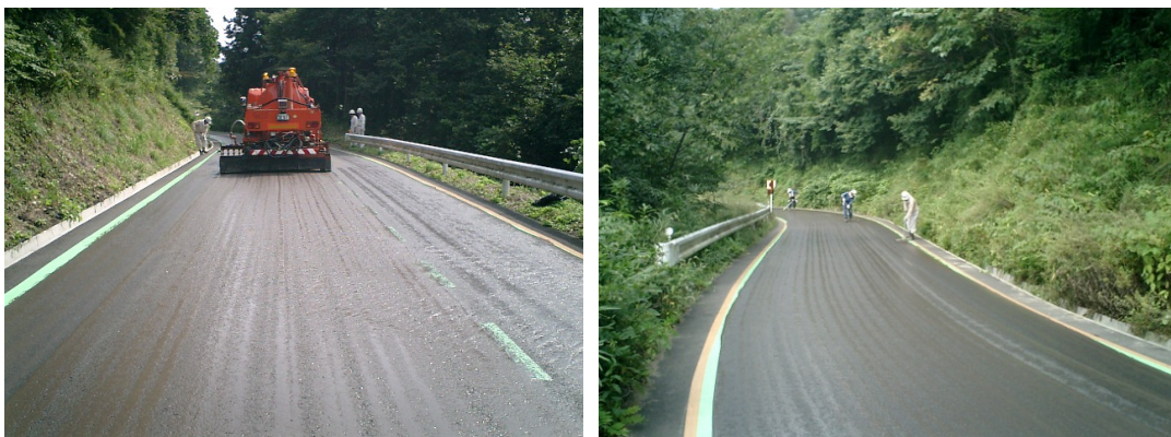
写真 6.8 調査箇所 C の施工時の状況
