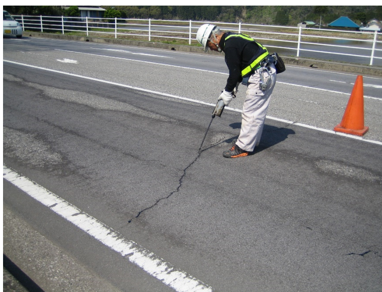
写真 3.3 シール材注入工法の施工状況
