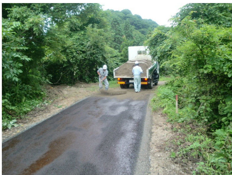
写真 3.9 チップシール工法の施工状況
