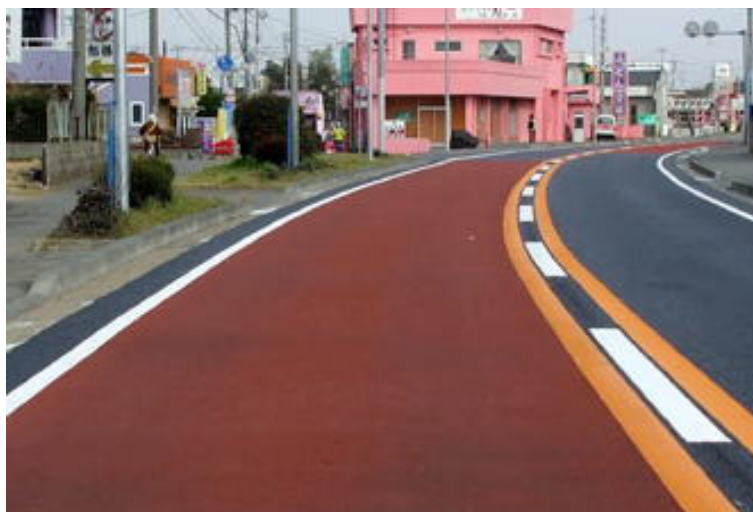
写真 3.11 表面処理工法（樹脂系表面処理） 6)
