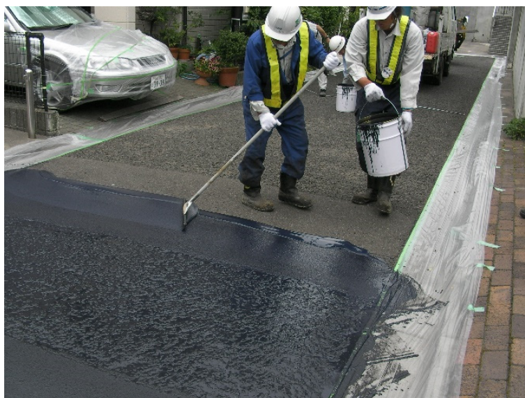
写真 3.12 アスファルト乳剤モルタルの施工状況
