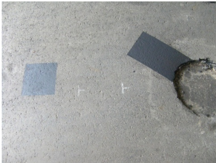
写真 5.17 微細なひび割れにフォグシールを施工した状況
