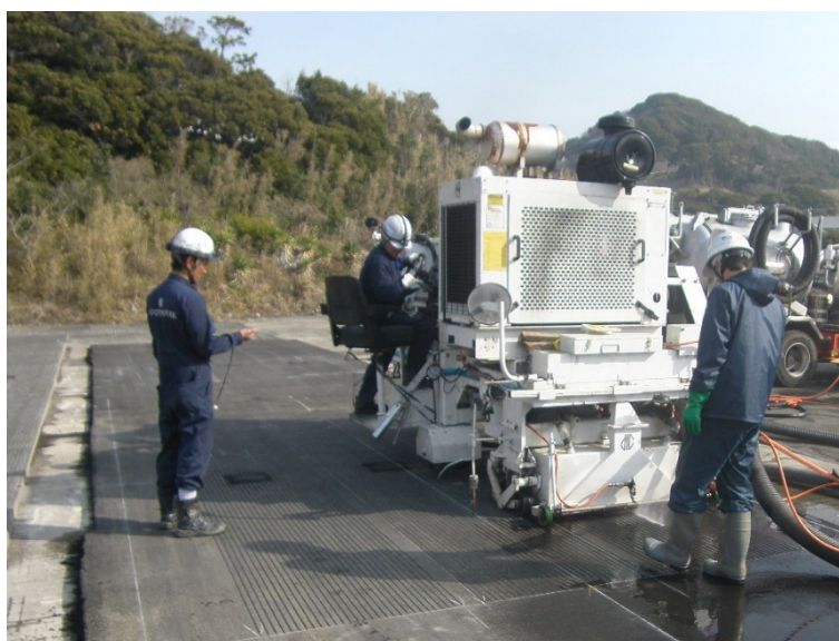
写真 3.5 グルーピング工法の施工状況
