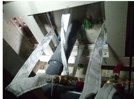
(d) 不織布および注入口のセット
