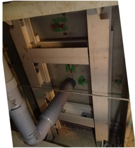
(b) H 形鋼組立完了
