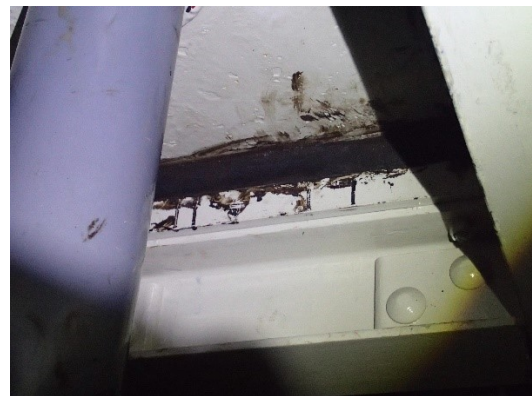
(f) CA モルタル充填完了
