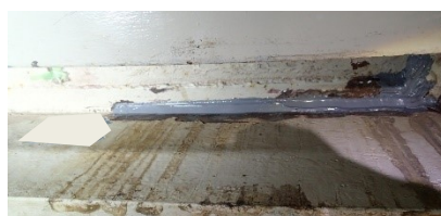
(g) き裂部の止水処置
