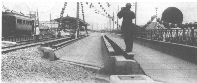
図 1.1 東京市街線建設工事における BP 式鋼鉄道橋の架設状況 9)
