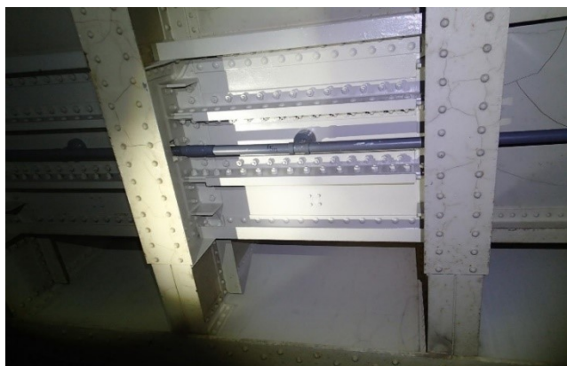
図 5.55 対象橋梁と同形式および寸法での従来下支えの実施状況
