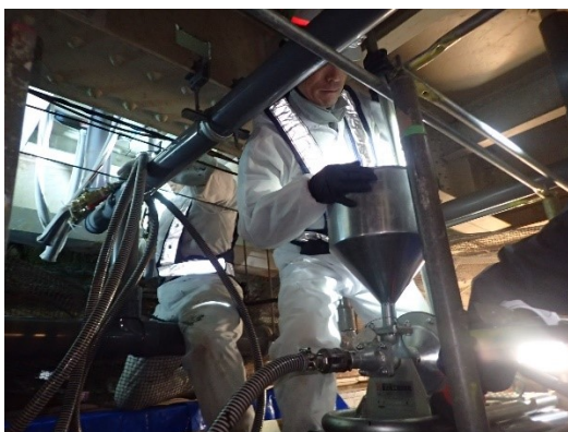
(e) モルタルポンプによる CA モルタル充填
