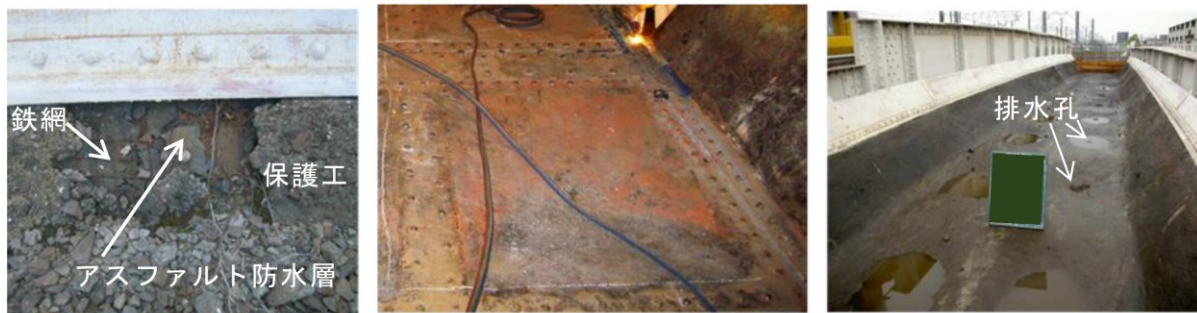
(a) 保護工および防水層 (b) BPの上表面 (c) 保護工上面
