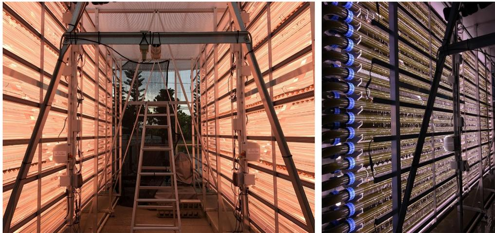
図 3-7 LED 照明設置状況（1,100 L タイプ PBR）
