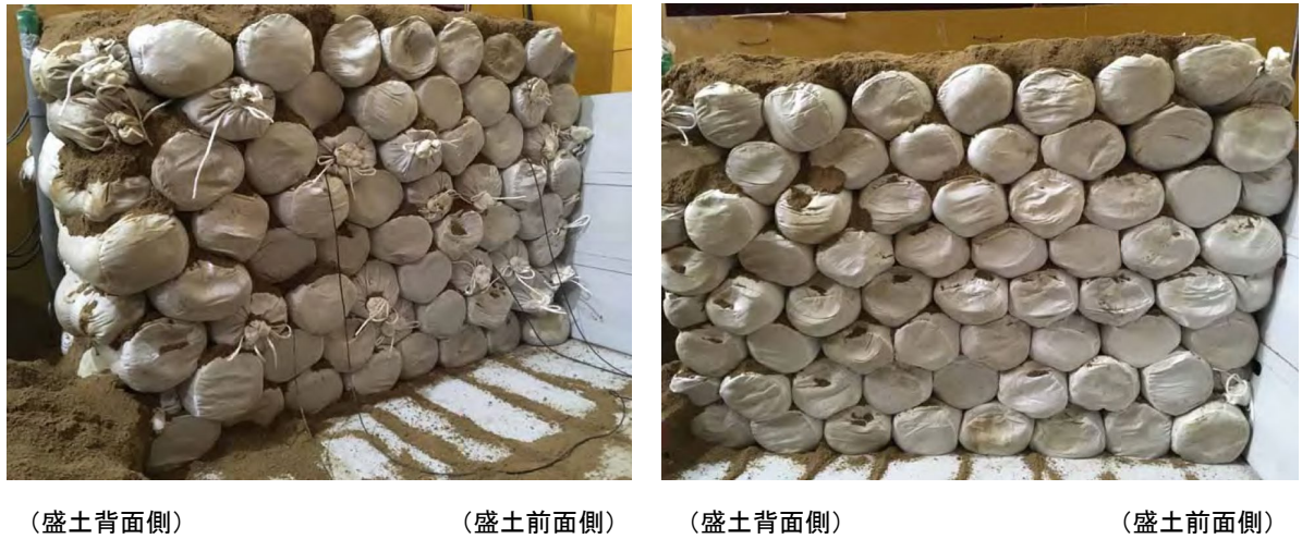
(a) 手前から4列目の土のう積層
