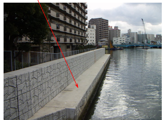
写真-3.1-2 自立式鋼管矢板による河川護岸・防潮堤の耐震補強事例（木津川）
