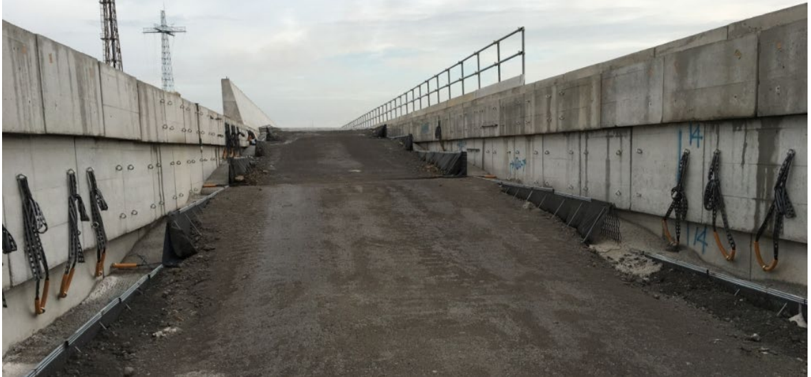
写真-5.6-1 設計区間①終点部（施工時）：区間①側を望む
