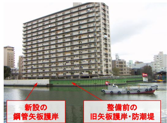
写真-3.1-1 自立式鋼管矢板による河川護岸・防潮堤の耐震補強事例（安治川）
