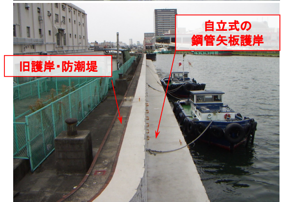
写真-3.1-1 自立式鋼管矢板による河川護岸・防潮堤の耐震補強事例（安治川）
