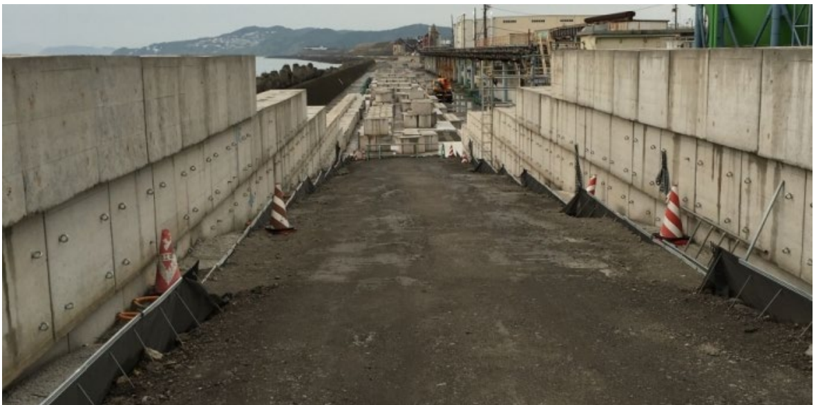
写真-5.6-2 設計区間①終点部（施工時）：区間②側を望む
