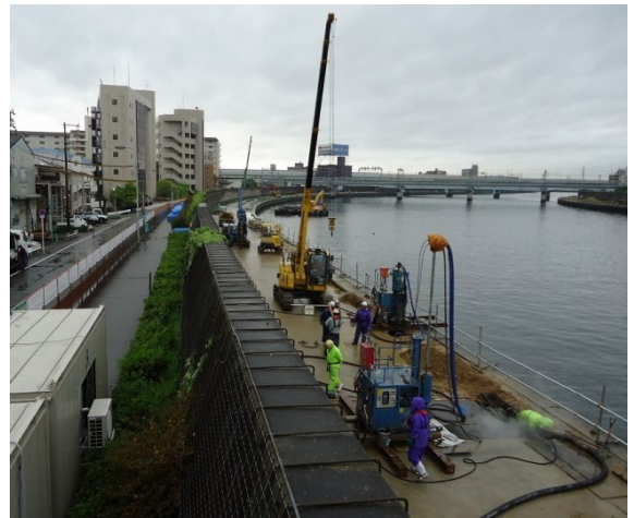
写真-4.6-1 高水敷における高圧噴射攪拌工の施工状況（工事中）
