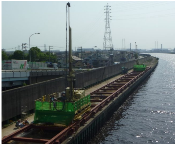
写真-4.6-1 高水敷における高圧噴射攪拌工の施工状況（工事中）
